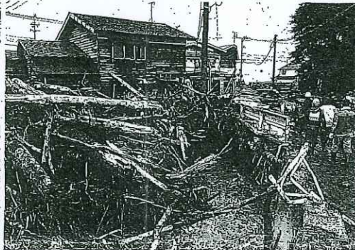
【写真上】三厩町の土砂崩れで倒壊した家屋。2時24分ごろに発生した。現在、関係機関で調査中。
